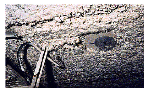
Flocage de plafond
