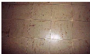
Dalles de sol
