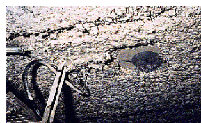
Flocage de plafond
